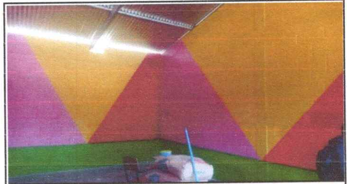
Foto 4: Pintura del interior de las aulas
