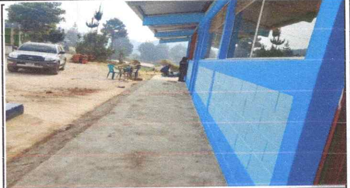
Foto 2: Cambio de techo
